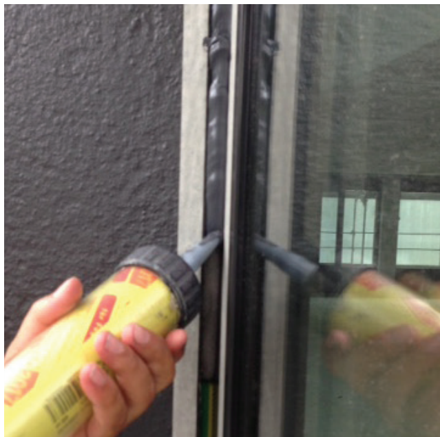
Befüllen der vorbereiteten Fuge mit dem Dichtstoff
