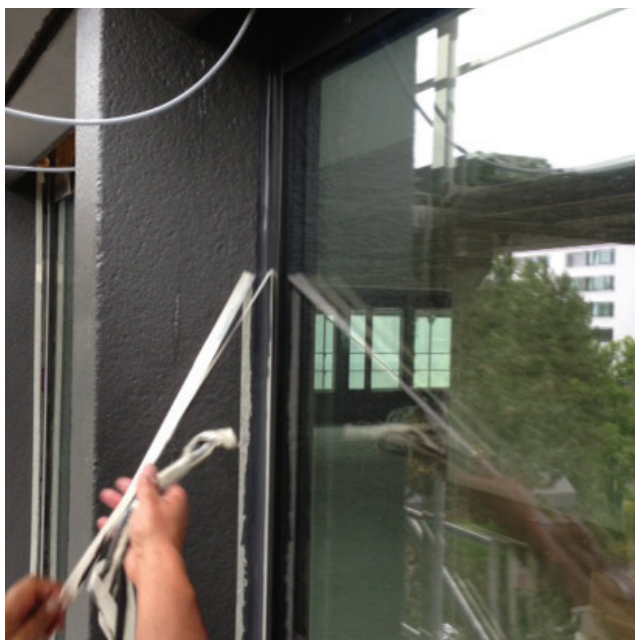
Entfernen der Abdeckbänder
