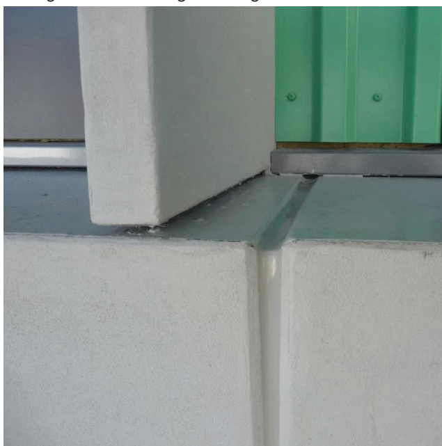
Bild einer fertigen Fuge
