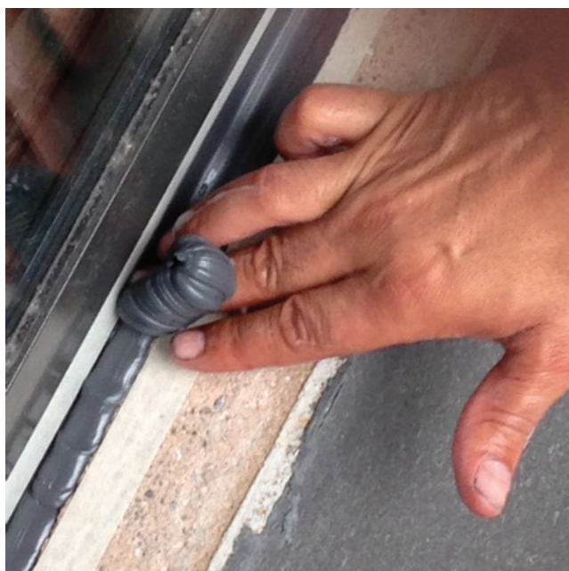
Entfernen des überschüssigen Materials
