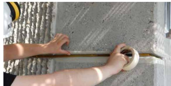
Gomastit 2060 ist in diversen Weiss- und Grautönen erhältlich. Dadurch integriert sich die Fuge hervorragend in den Fassaden. SMP sind anstrichverträglich. Bewegungsfugen werden üblicherweise nicht vollflächig überstrichen, da Wand- oder Fassadenfarben eine geringere Elastizität haben als die Dichtstoffe.
