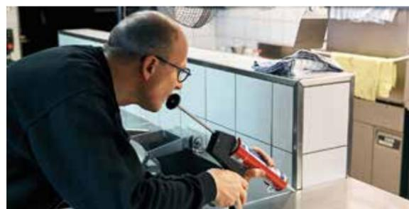
Wollen Sie in einer Bäckerei oder einer Industrieküche Fugen erstellen? Gomastit 2060 kann unbedenklich zur Verfugung im Wand- und Bodenbereich in lebensmittelverarbeitenden Betrieben verwendet werden. Für diese Bestätigung wurde der Dichtstoff vom Institut ISEGA auf die Migration nach EN 14338 geprüft.
